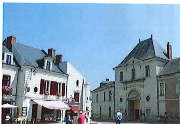
L'ardoise recouvre les toitures à forte pente
