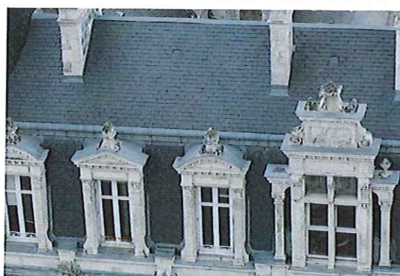
Toiture en ardoises neuves
