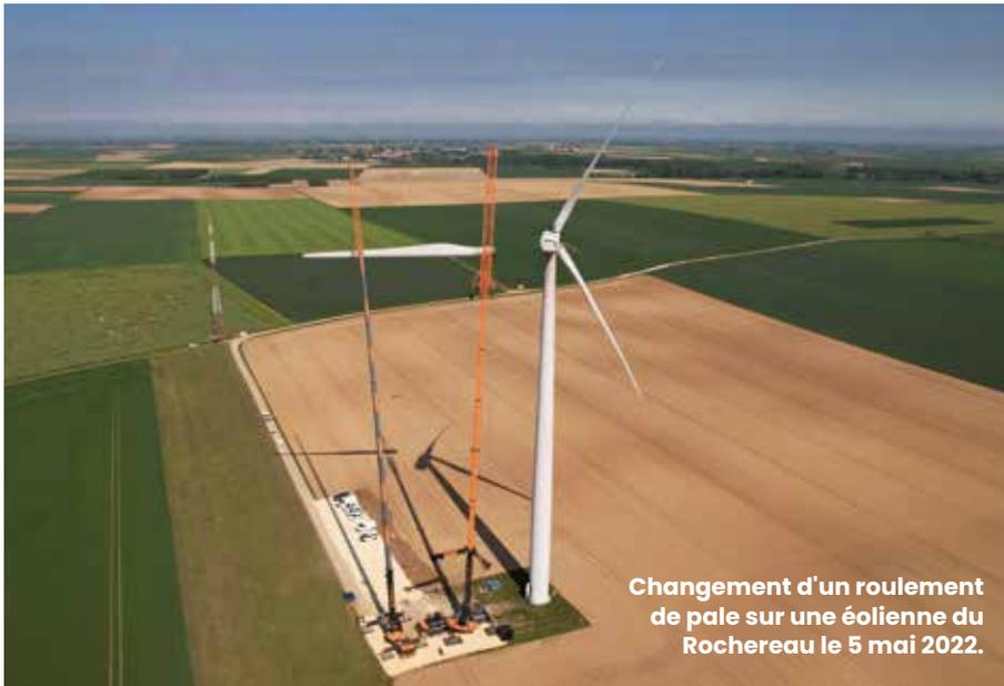
Changement d'un roulement de pale sur une éolienne du Rochereau le 5 mai 2022.
